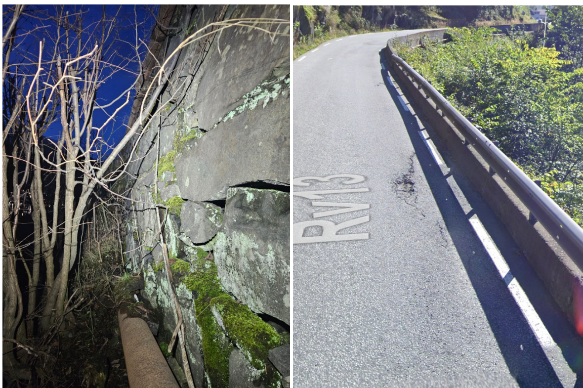
Figur 5: Bilde av natursteinsmur med mage ved profil 365 (bildepunkt 4) og bilde av deformasjon i veidekket fra veibilde ved profil 465
