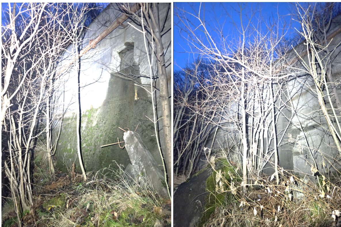
Figur 4: Bilde av betongmur ved profil 285 (bildepunkt 1) til venstre og profil 315 (bildepunkt 2) til høyre. Ved profil 315 kan en se bergblotning nede til venstre.
